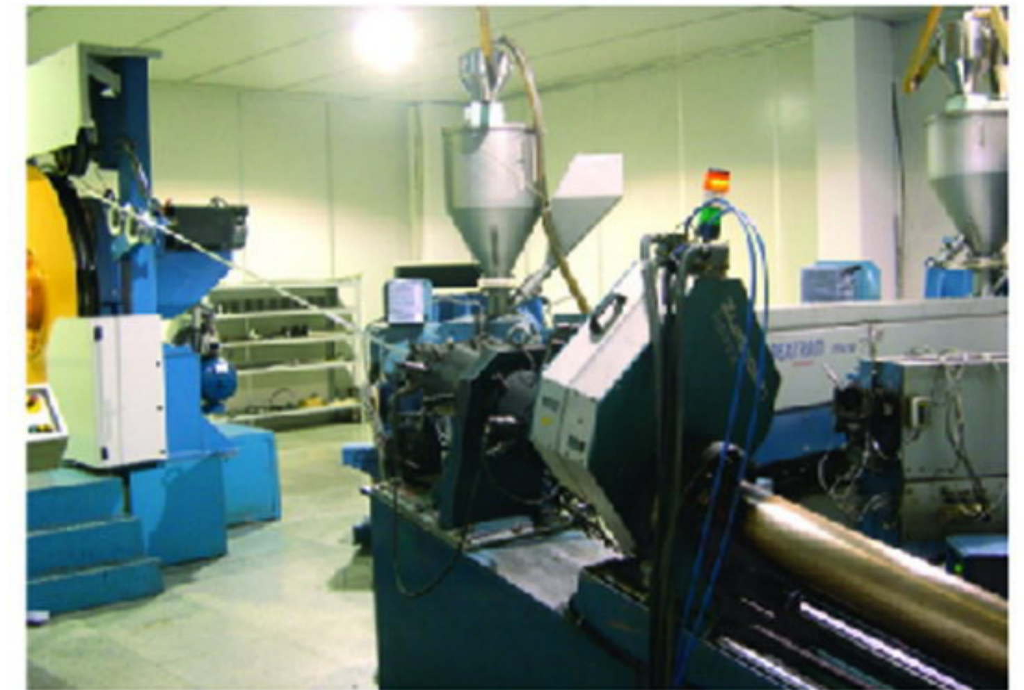
引进芬兰麦拉菲尔公司110kV交联生产线 110kV ccv line from MAILLEFER
